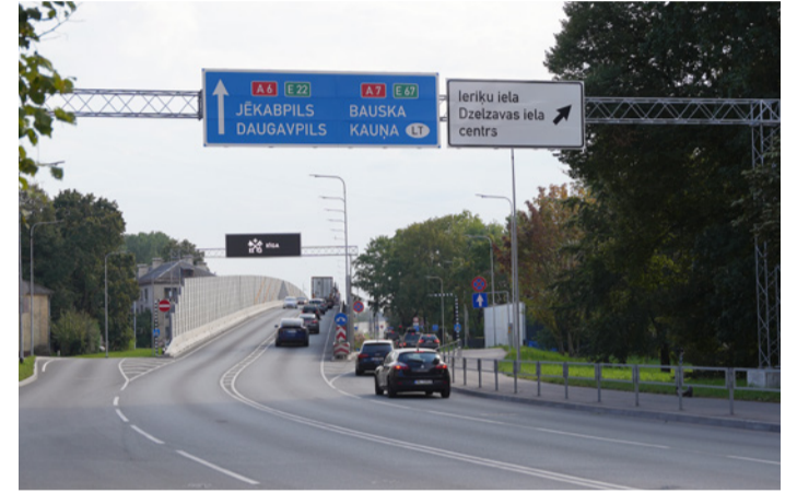
▲ Gustava Zemgala gatve pēc remonta. Foto – Rīgas dome
