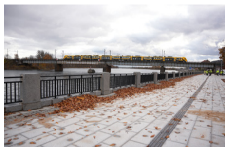
▲ Mūkusalas ielas krasta promenādes pārbūve. Foto – Rīgas dome
