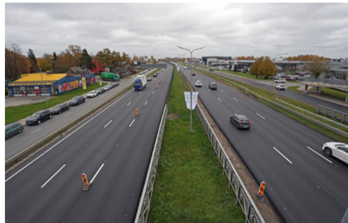
▲ Kārļa Ulmaņa gatve pēc remonta. Foto – Rīgas dome
